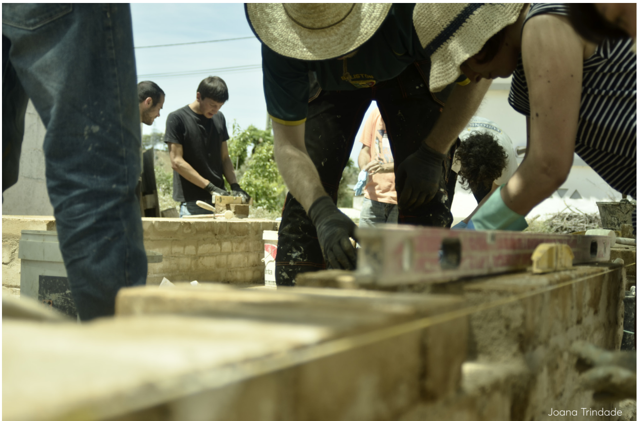
Experiência de Longa duração Desenhar e Construir com BTC: Construção de alvenaria em BTC
