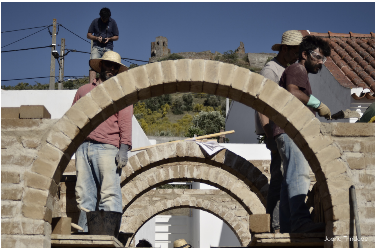
Experiência de Longa duração Desenhar e Construir com BTC: Construção de arcos em BTC
